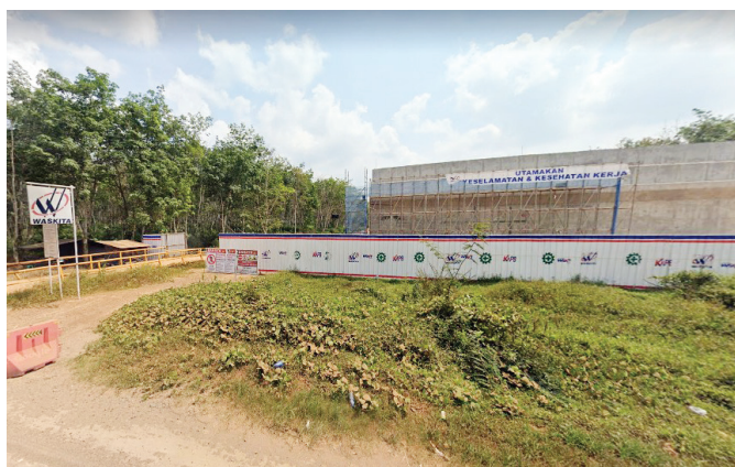
PROGRES - Konstruksi jembatan tol yang di bangun diatas jalan lintas Palembang -Betung KM 24 Kabupaten Banyuasin
